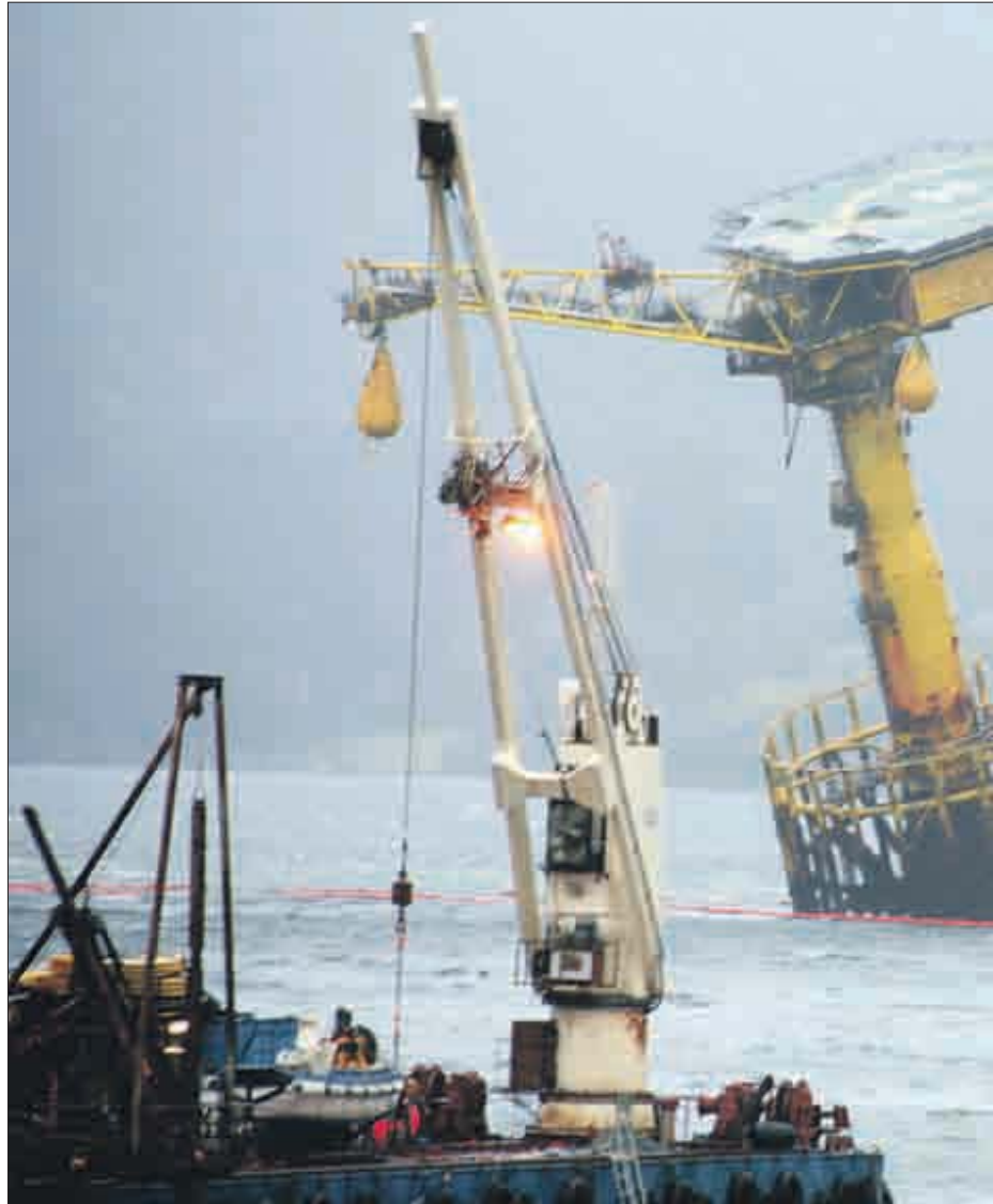
I 2008 fekk AF Decom den første dispensasjonen til å dele opp hittil to oljebøyer ute på fjorden, Kittiwake. No er seksjonering på fjorden.
